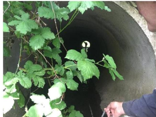
Metral M1 - Garside Rd Culvert
