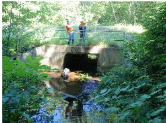
3). Pool Below Culvert
